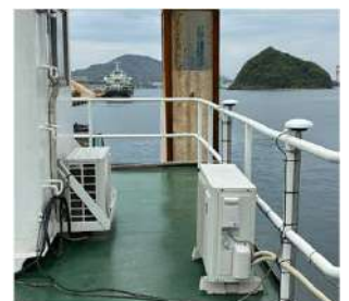
▲GNSSアンテナ
