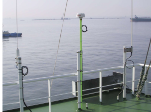
GNSSアンテナ設置状況
