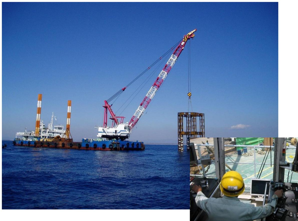
C-NAVIは、クレーントップに設置したGNSSと、船体に設置したGNSSコンパスを組み合わせた、クレーン船(ガット船)の施工支援システムです。構造物の据付作業や浚渫作業、捨石投入作業などへの応用が可能です。クレーンの作業位置を高精度に誘導ができ、さらにGNSSコンパスの船体方位データを利用した、クレーン旋回角度の描画・管理も可能です。無線LANやモバイル端末を利用すれば、同時に作業を行う他の船団との情報共有も可能であり、さらに陸上の現場事務所など、遠隔地での施工監視もできます。
